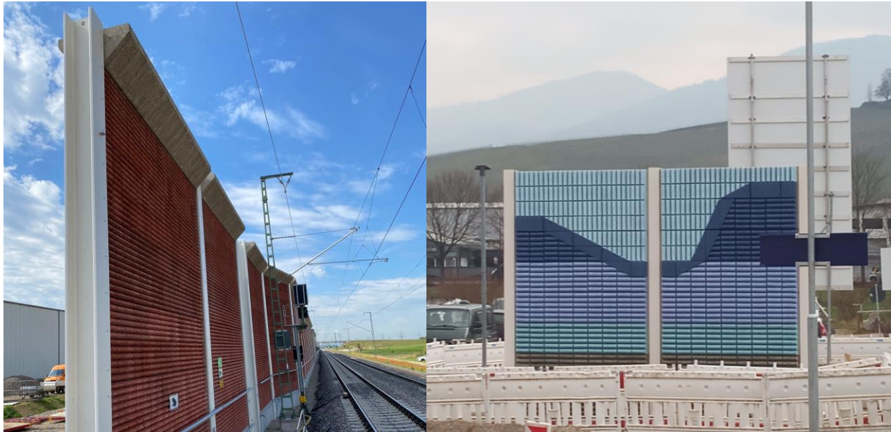
Mit dem Bau der Schallschutzwände wurde begonnen
